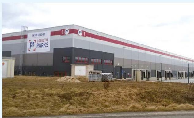
Logistic park Mstěnice Retenční nádrž o objemu 1 700 m 3 (použity byly systémy Q-Bic, Q-BB)
