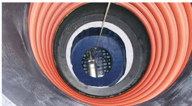
Pohled do šachtové roury Tegra 600 s šachtovým adaptérem na boxu Q-Bic
