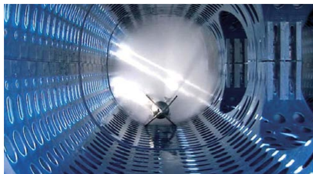
Tlakové čištění revizního kanálu v systému Q-Bic
