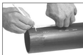
Označení požadované zásuvné délky
