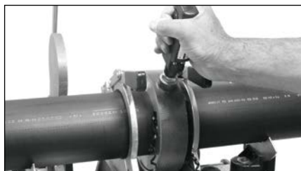
Srovnání konců potrubí integr. hoblíkem
