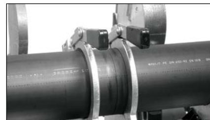
Správně připravené potrubí ke svařování
