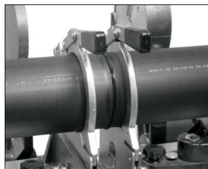
Chladnutí svařeného spoje
