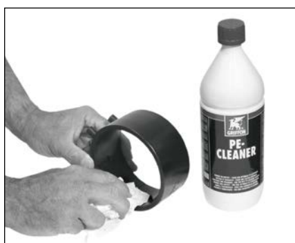
Ošetření vnitřního povrchu elektrotvarovky PE čisticím přípravkem
