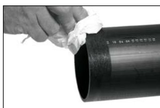
Ošetření konců potrubí PE čisticím přípravkem
