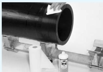
Odmastěte svařovací plochu vhodným prostředkem. Pokud bude nutné úplně nasunutí elektrospojky, trubku odmastěte v délce odpovídající délce elektrospojky.
