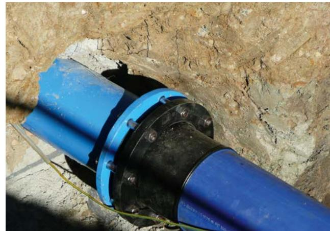
Spoj na tupo a přírubový spoj d280 mm ze stavby ve Štítarech
