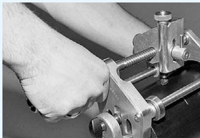
Odstraňte zoxidovanou vrstvu pomocí rotační škrabky (min. na délku tvarovky +1 cm na každou stranu). Dodržujte předepsanou minimální tloušťku škrabkou odstraněné vrstvy a zároveň neprekročte maximální povolenou redukcí tloušťky trubky.
