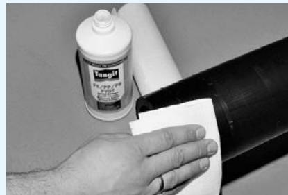
Očistěte svařovací plochu od mastnot pomocí odmašťovacího ubrousku nebo vhodného čisticího prostředku, např. savým papírem. Trubku odmastěte v odškrábaném úseku po celém jejím obvodu.
