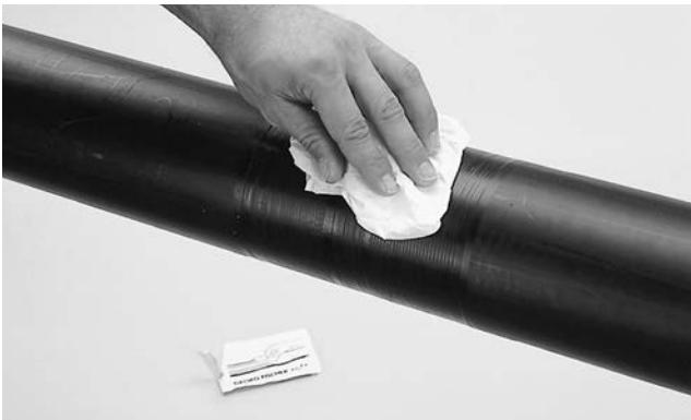
Výjimka: Pokud dojde při montáži ke styku rukou se svařovací plochou, musí být tvarovky vyčištěny čisticím prostředkem na PE.
