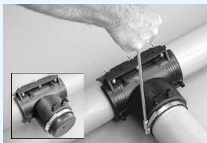
Nasaděte připojovaný kus až na doraz do odbočovací tvarovky a zafixujte ho pomocí uchycení. Pokud jste se dotkli nebo jinak znečistili svařovací plochu, očistěte a odmastěte ji.
