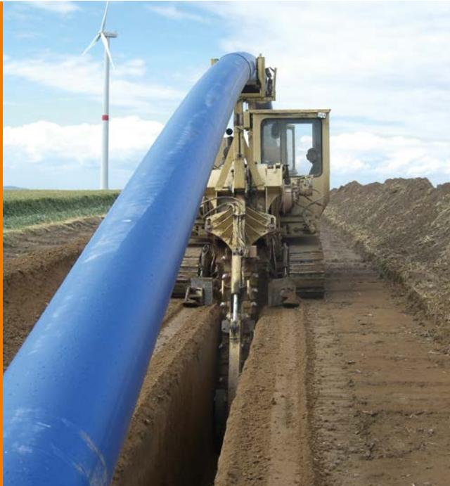
**Krátkodobě přípustné minimální poloměry ohybu pro pluhování nebo frézování**
