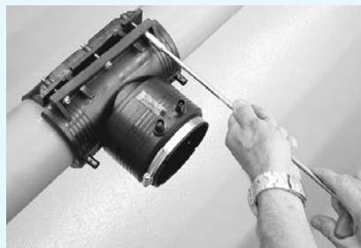
Umístěte tvarovku na trubku. V ideální pozici ji pomocí šroubů postupně utáhněte do kříže, až po zarážku na spodní části. Odbočky SATURN pro průměry potrubí větší než 250 mm se dodávají bez spodní části. Tyto odbočky je nutné připevnit na trubku pomocí přítlačného nářadí Top Load.
