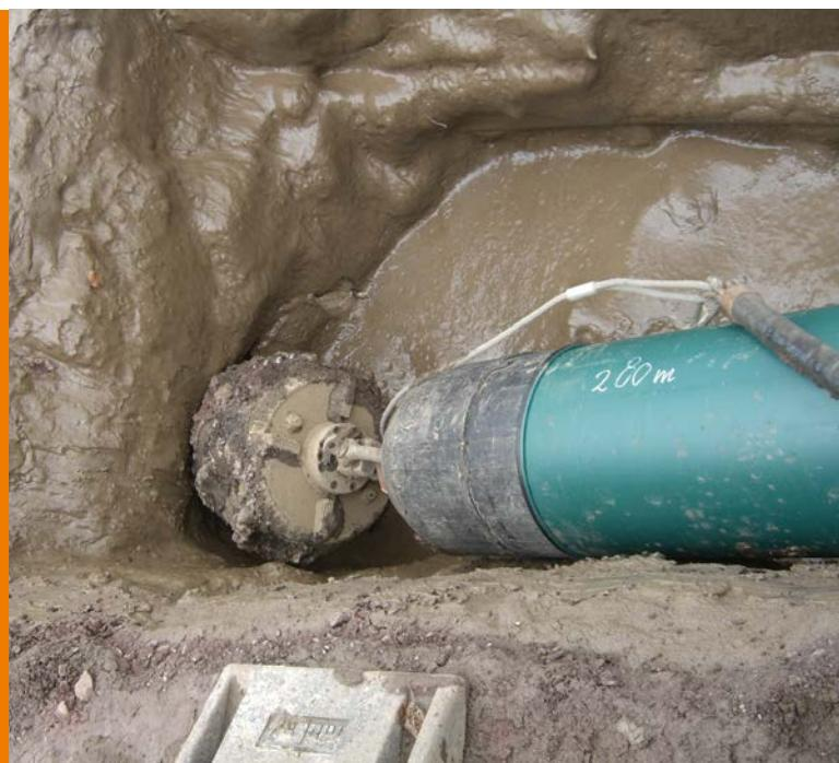
Při rozširování, opět s podporou výplachové směsi, dochází k roztačení zeminy a zvětšení průměru původního pilotního vrtu až na požadovanou velikost, podle průměru vtahovaného potrubí. Posledním krokem zatažení PE potrubí do rozšířeného vrtu. Vtahování potrubí probíhá opět s podporou bentonitové směsi, která snižuje tření a umožňuje zatahovat větší délky potrubí v jednom úseku. Směs navíc vyplní a utěsní prostor mezi potrubím a okolní zeminou.
