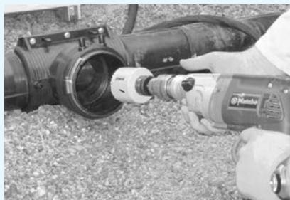
Pro navrtání použijte elektrickou vrtačku s vhodným kruhovým vrtákem. Dodržte maximální přípustný průměr otvoru pro odbočku, který je 65 nebo 86 mm, dle použité odbočky SATURN.
