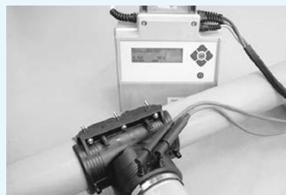
Nyní můžete svařovat pomocí vhodných svařovacích přístrojů. Použijte svařovací data pro svařování připojovaného kusu na sedlovou odbočku. Dbejte na správné nasazení připojovaného kusu do tvarovky SATURN. Po svařování zkonztrolujte indikátory na displeji svařovací jednotky.
