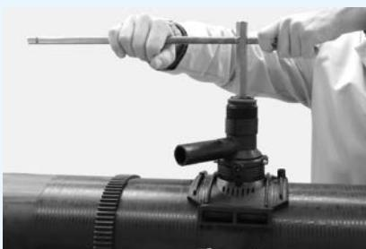
Z T-kusu odejměte víčko a chráňte ho před znečištěním. Nasaděte navrtávací klíč a otáčejte ve směru hodinových ručiček. Po dosažení pozice „stop“ otáčejte klíčem proti směru hodinových ručiček, dokud nedosáhnete pozice „stop“ nahore.
