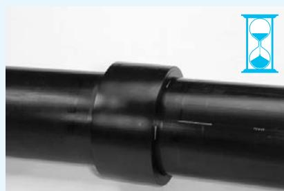
Dokud neuplyne stanovená minimální doba chlazení, neprovádějte tlakovou zkoušku.
