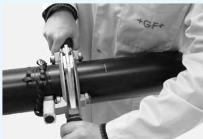
Tvarovku nechte zabalenou v ochranném obalu až do okamžiku, kdy půjdete svařovat. Z trubky nejprve odstraňte hrubé nečistoty, poté zoxidovanou vrstvu pomocí rotační škrabky (minimálně na délku tvarovky +1 cm na každou stranu). Dodržte předepsanou minimální tloušťku škrabkou odstraněné vrstvy a zároveň neprekročte maximální povolenou redukci tloušťky trubky.
