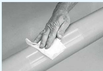
Očistěte svařovací plochu od mastnot pomocí odmašťovacího ubrouska nebo vhodného čisticího prostředku, např. sa-vým papírem. Trubku odmastěte v od-škrabaném úseku po celém jejím obvo-du.
