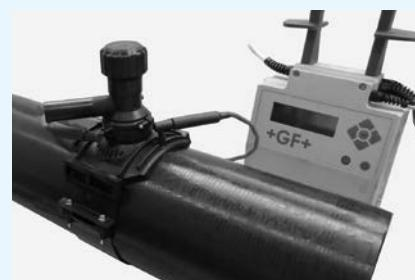
Otočte směr přípojky do požadované pozice. Nyní můžete svařovat pomocí vhodných svařovacích přístrojů. Věnujte pozornost návodu k obsluze svářečky. Kontrolujte proces svařování.
