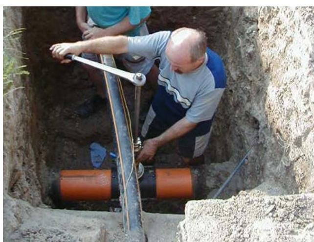
Vysazení přípojky pomocí sedlové tvarovky
