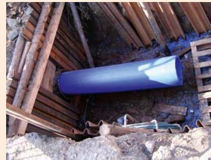
Sanace ocelového vodovodního přívaděče DN 400 v Praze – Chuchli vyřešila časté poruchy a zlepšila kvalitu pitné vody
