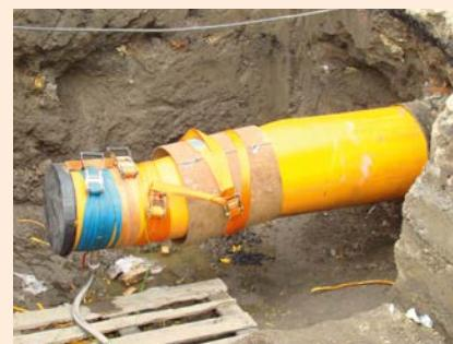
Sanace plynovodu DN 500 na ulici Nuselské v Praze proběhla za rušného provozu v těsné blízkosti tramvajového pásu
