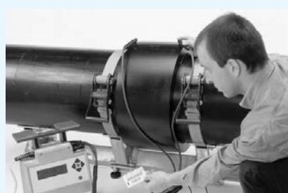
Proveděte svar podle návodu k používání svařovací jednotky. Porovnejte celkovou dobu svařování s daty uvedenými na etiketě s čárovým kódem.
