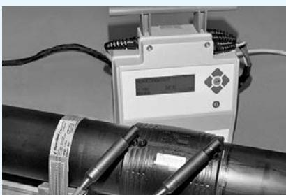
Nyní můžete svařovat pomocí vhodných svařovacích přístrojů. Věnujte pozornost návodu k obsluze. Sledujte proces svařování.
