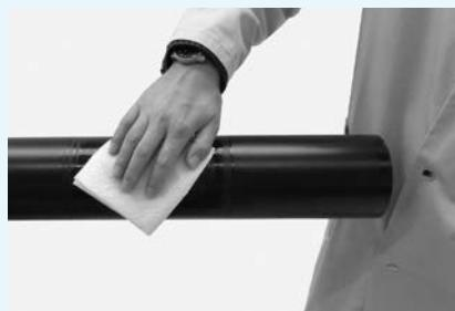
Očistěte svařovací plochu od mastnot pomocí odmašťovacího ubrouska nebo vhodného čisticího prostředku, např. savým papírem. Trubku odmastěte pouze v oškrabaném úseku a po celém obvodu trubky.
