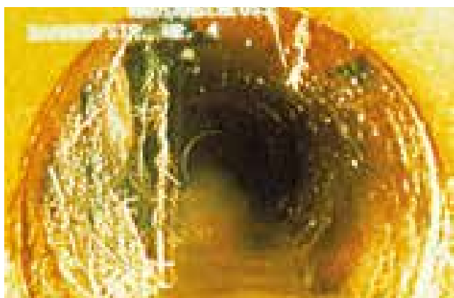
Ukázky kanalizačního potrubí se zřetelnými prasklinami (stav III)
