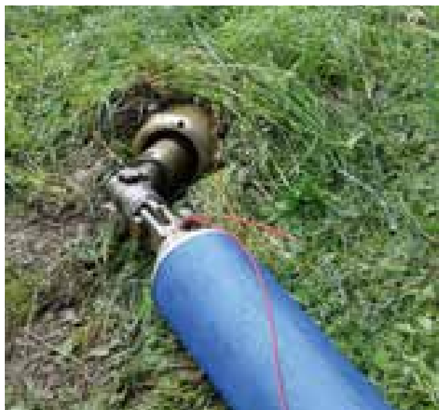
Pokládka vodovodního potrubí SafeTech RC d225 pro společnost Kofola a.s. v Krnově
