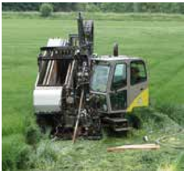
Pokládka vodovodního potrubí SafeTech RC d225 pro společnost Kofola a.s. v Krnově
