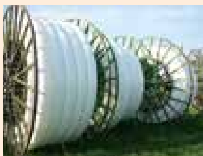
Sanace kanalizačního potrubí DN 300 a DN 400 v Praze Běchovicích probíhala současně s výměnou kanalizačních šachet
