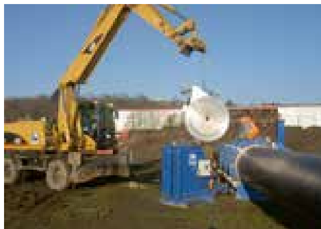
Sanace ocelového vodovodního přívaděče DN 800 v Chrudimi technologií Close-Fit (na stavbě)
