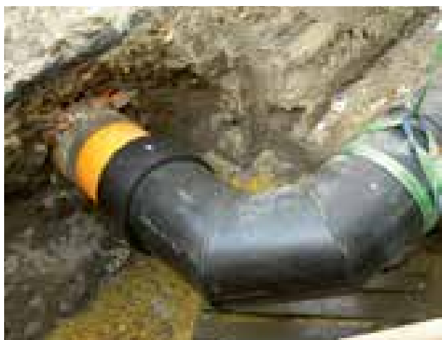
Napojení potrubí Compact Pipe na segmentový oblouk pomocí elektrospojky
