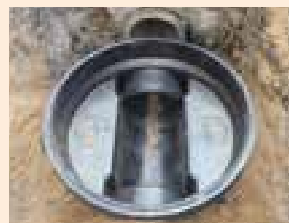
Sanace kanalizačního potrubí DN 300 a DN 400 v Praze Běchovicích probíhala současně s výměnou kanalizačních šachet
