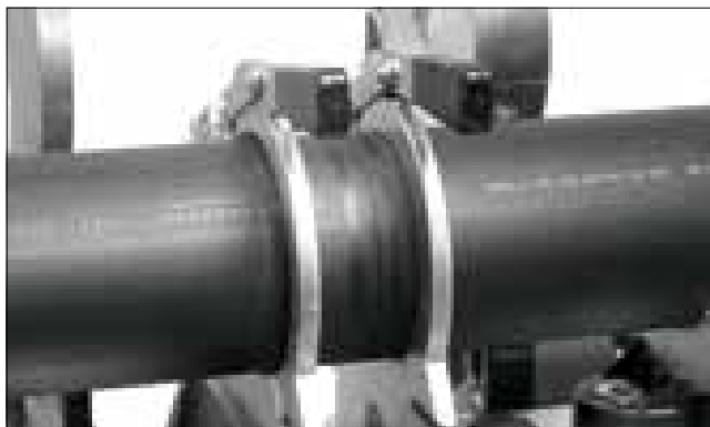
Správně připravené potrubí ke svařování
