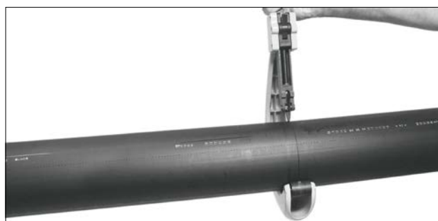
Řez potrubí ruční rotační řezačkou
