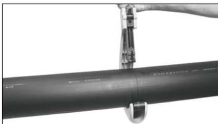
Řez potrubí ruční rotační řezačkou
