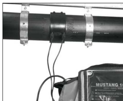
Svařování pomocí elektroodporového
