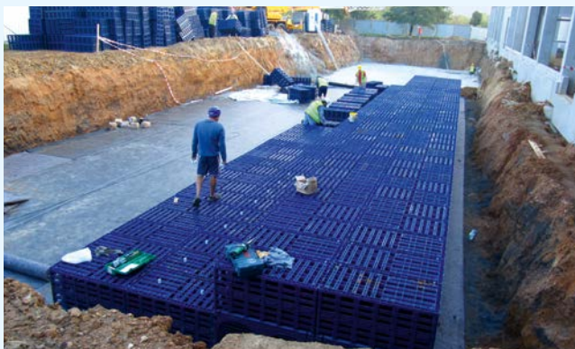
Asko Olomouc, prodejna nábytku Retenční nádrž o objemu 311 m 3 (použity byly systémy Q-Bic, Q-BB, regulace odtoku)
