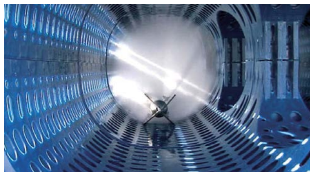
Tlakové čištění revizního kanálu v systému Q-Bic
