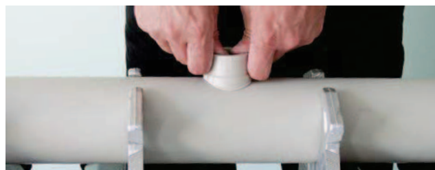
4/ Nahřáté sedlo nasuneme do nahřátého otvoru a fixujeme cca 16 s. Po uplynutí jedné hodiny lze napustit vodou a namáhat tlakem.
