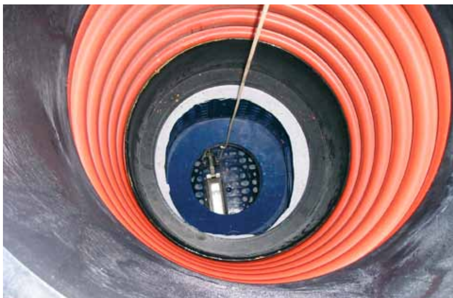
Pohled do šachtové roury TEGRA 600 s šachtovým adaptérem na boku Q-Bic
