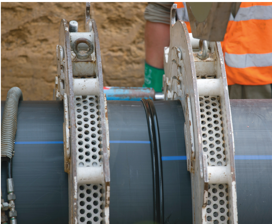
Obr. 4 – Čerstvě provedený svar na tupo a následná 75 minut dlouhá doba chlazení
