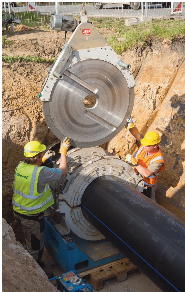
Obr. 3 – Svařování takto velkých průměrů už vyžaduje asistenci techniky a pokročilé znalosti svářečů.
