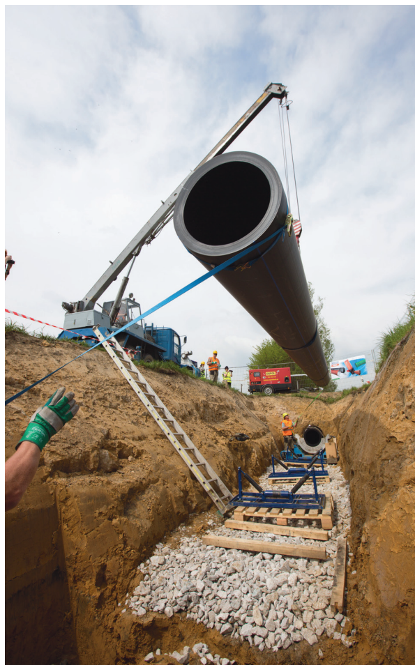
Obr. 2 – Montážní jáma musela umožnit svařování nového potrubí metodou na tupo a následné zatažení.
