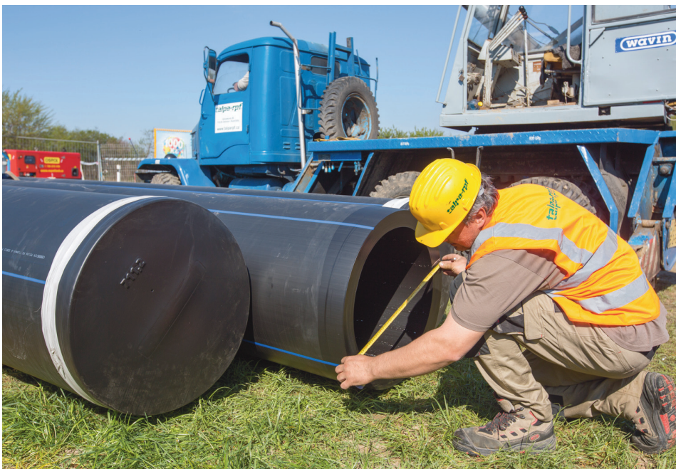
Obr. 1 – Důkladná příprava zabránila vzniku komplikací při montáži, svařování i zatahování
