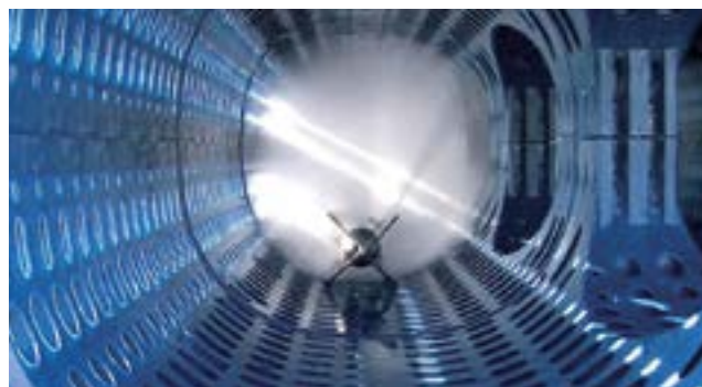
Tlakové čištění revizního kanálu v systému Q-Bic
