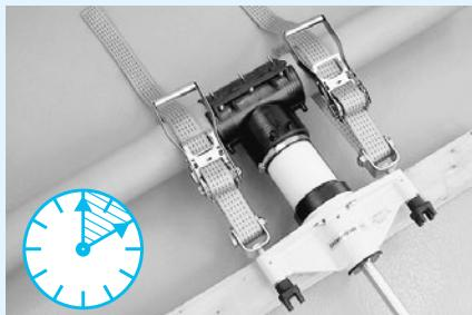
S navrtáním odbočky na hlavní řad začněte až po uplynutí doby potřebné k ochlazení. Navrtávejte podle montážního předpisu pro práci s navrtávacím zařízením.
