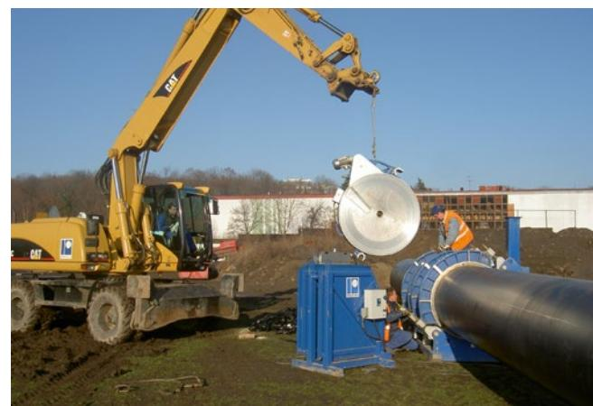
Sanace ocelového vodovodního přivaděče DN 800 v Chrudimi technologií Close-Fit (na stavbě)
