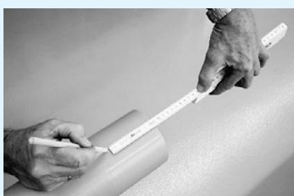
Odmastěte plochu připojovaného kusu v místě oškrábaní pomocí přípravků k tomu určených. Označte hloubku vsunutí spojovacího kusu.
