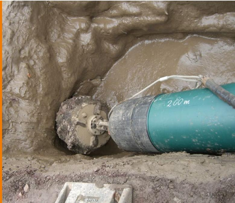
Při rozšiřování, opět s podporou výplachové směsi, dochází k roztlačení zeminy a zvětšení průměru původního pilotního vrtu až na požadovanou velikost, podle průměru vtahaného potrubí. Posledním krokem zatažení PE potrubí do rozšířeného vrtu. Vtahování potrubí probíhá opět s podporou bentonitové směsi, která snižuje tření a umožňuje zatahovat větší délky potrubí v jednom úseku. Směs navíc vyplní a utěsní prostor mezi potrubím a okolní zeminou.
