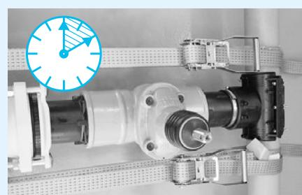
Dodržte stanovenou minimální dobu chlazení před navrtáním otvoru do trubky. Navrtávejte podle montážního předpisu pro práci s navrtávacím zařízením. Dodržte maximální přípustný průměr otvoru pro odbočku 65 nebo 86 mm.
