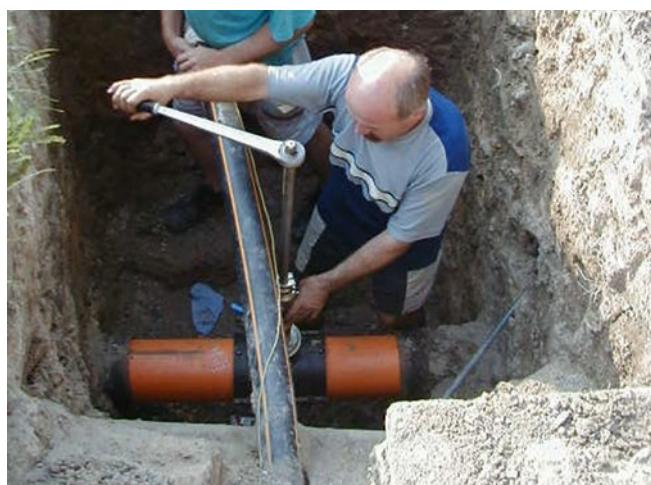
Vysazení přípojky pomocí sedlové tvarovky
