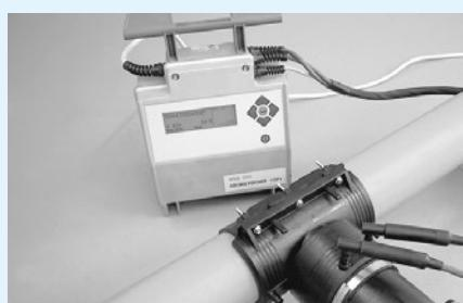
Nyní začněte svařovat pomocí vhodných svařovacích přístrojů. Použijte svařovací data pro svařování připojovaného kusu na sedlovou odbočku. Dbejte na správné nasazení připojovaného kusu do tvarovky SATURN.
