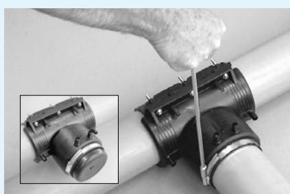
Nasaděte připojovaný kus až na doraz do odbočovací tvarovky a zafixujte ho pomocí uchycení. Pokud jste se dotkli nebo jinak znečistili svařovací plochu, očistěte a odmastěte ji.
