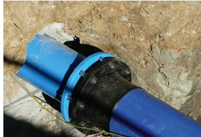
Spoj na tupo a přírubový spoj d280 mm ze stavby ve Štítarech
