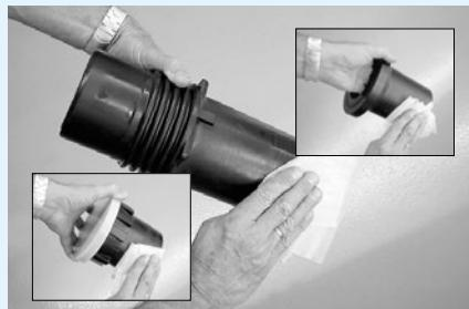
Odmastěte plochu připojovaného kusu v místě oškrábání pomocí přípravků k tomu určených. Označte hloubku vsunutí spojovacího kusu.
