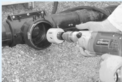
Pro navrtání použijte elektrickou vrtáčku s vhodným kruhovým vrtákem. Dodržte maximální přípustný průměr otvoru pro odbočku, který je 65 nebo 86 mm, dle použité odbočky SATURN.
