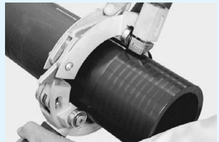
Očistěte připojovaný kus od hrubých nečistot a jeho hladký konec zavleťte zoxidované vrstvy rotační škrabkou. Délka oškrábání se musí rovnat nejméně hloubce vsunutí do odbočky. Dodržte minimální tloušťku oškrabání a maximální přípustné zmenšení tloušťky stěny. Postupujte podle montážního předpisu pro připojovaný kus.
