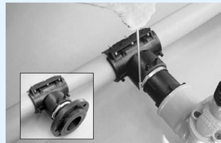
Nasaděte připojovaný kus až na doraz do odbočovací tvarovky a zafixujte ho pomocí uchycení. Pokud jste se dotkli nebo jinak znečistili svařovací plochu, očistěte a odmastěte ji.
