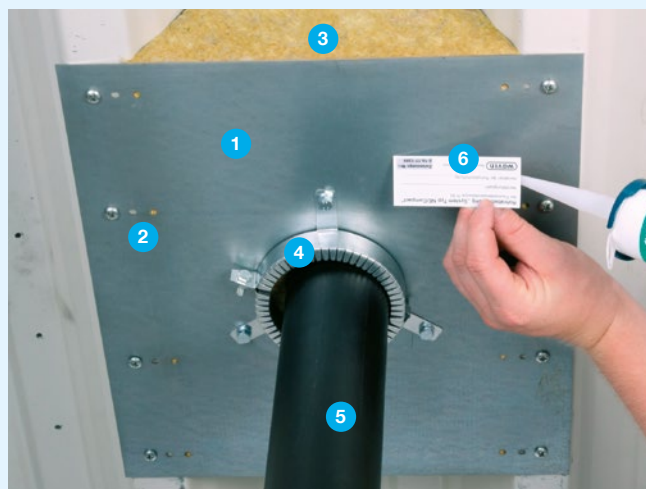
Protipožární set ke vtokům – příklad uložení
