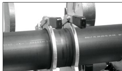
Správně připravené potrubí ke svařování
