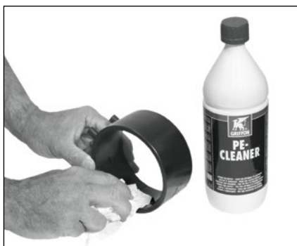
Ošetření vnitřního povrchu elektrotvarovky PE čisticím přípravkem
