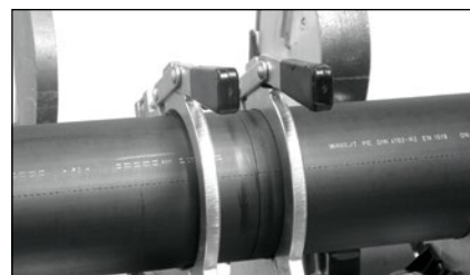
Správně připravené potrubí ke svařování
