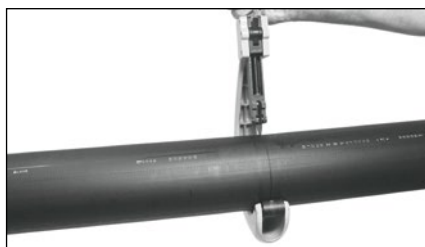
Řez potrubí ruční rotační řezačkou
