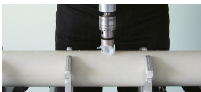
1/ Speciálním vrtákem vyvrtáme otvor pro potrubí.
