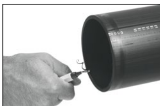
Odstranění otřepů a nerovností řezu
