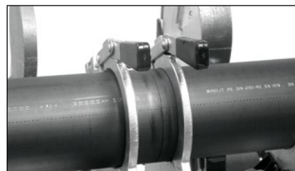
Správně připravené potrubí ke svařování
