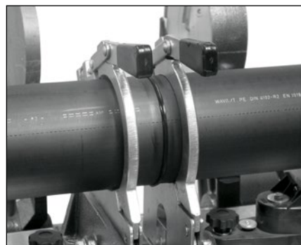
Chladnutí svařeného spoje
