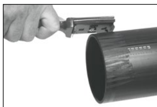
Oškrabání konců potrubí ruční škrabkou
